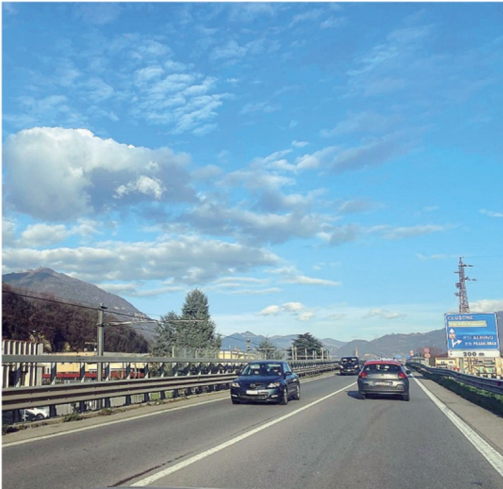
La strada statale 671 nel tratto fra Nembro e Albino. Sulla sinistra, la linea del tram
