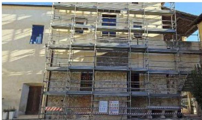
Il cantiere che si affaccia sul Giardino Barsanti, all'esterno del chiostro
